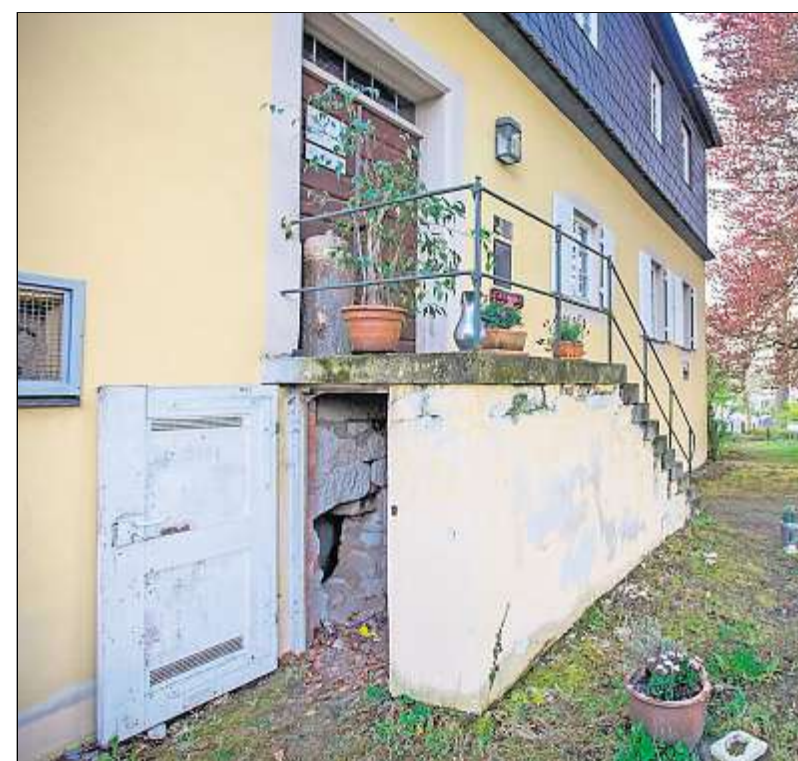
Versteckt unter der Treppe des Pfarrhauses liegt der Einstieg zum Gang.
